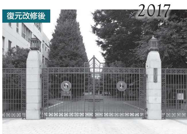
復元改修後の正門
