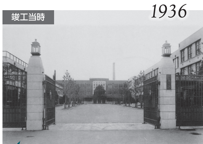
竣工当時の正門（『落成記念写真帖』より）
