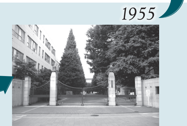
昭和30年に取り付けられた丸パイプを使用した門扉
