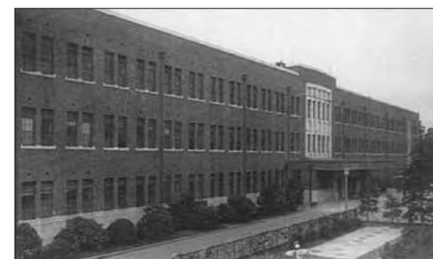
▲昭和7年竣工当時
