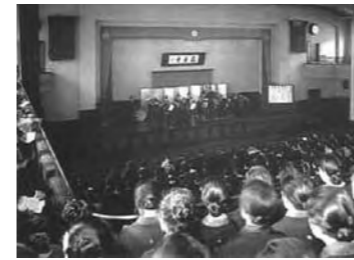
▲竣工当時の徽音堂内部
